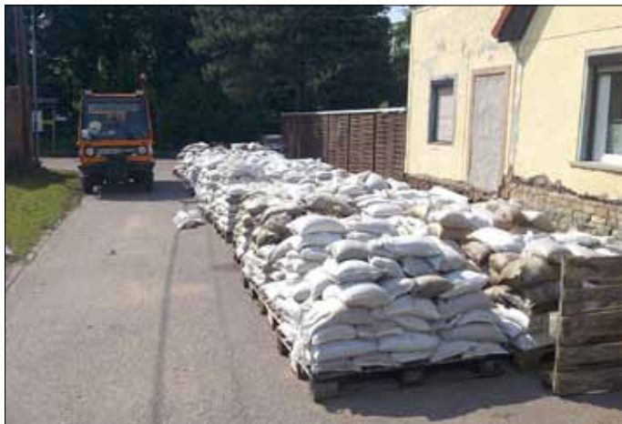
Ein Teil der verbauten Sandsäcke beim Rückbau
