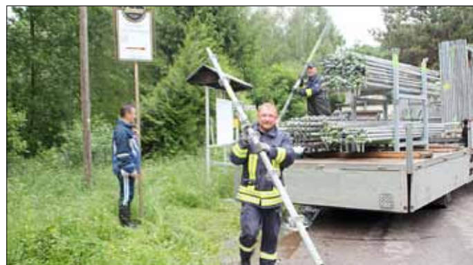
Beim massiven Erweitern der Steganlagen am Sonntag ... 220 Meter Gerüst und 400 Europaletten wurden verbaut.
