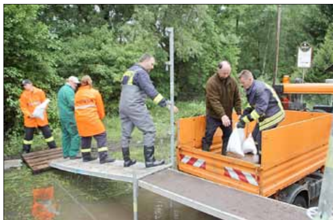
Feuerwehrkräfte, Anwohner und freiwillige Helfer sichern die Abwasserpumpstation
