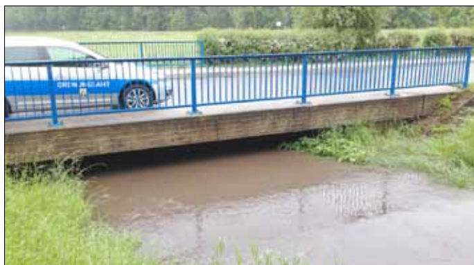
Brückenbauwerke und markante Stellen wurden durch das Ordnungsamt ständig kontrolliert. Hier: Poserna
